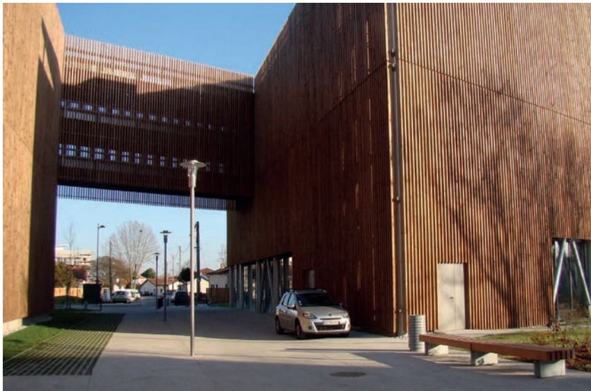
Parking silos au sein d'un écoquartier, écoquartier de Bègles Terres Sud. © a'urba
