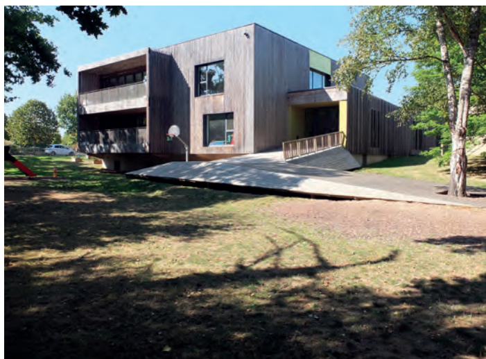
Équipement public construit dans une zone d'expansion des crues en ayant intégré le risque inondation. Maison de l'enfance, Montfort-sur-Meu (35). © EHESP
